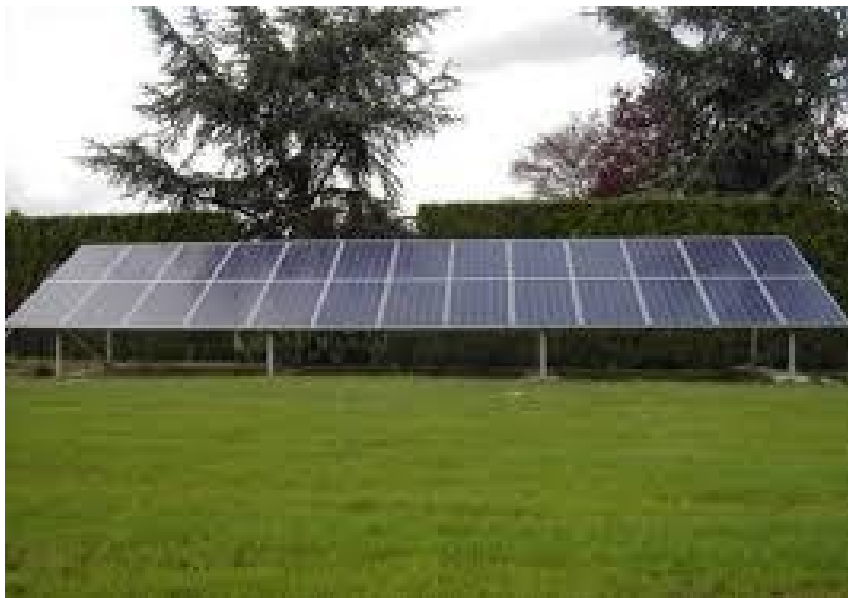
Afbeelding 3; 2 meter hoge grondopstelling voor tussen percelen
