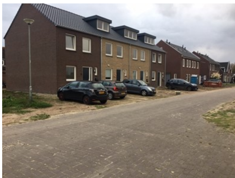
Siebengewald, St Jozefstraat, starterswoningen
