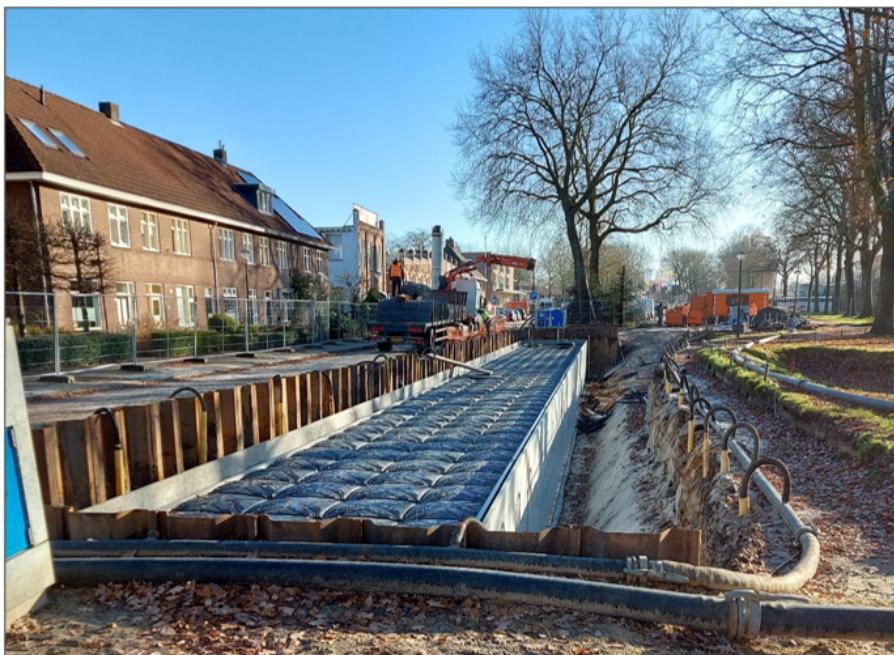
Afbeelding 10 Aanleg ondergrondse waterberging Parallelweg
