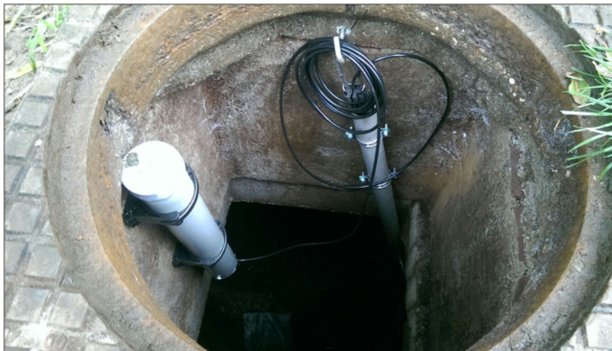
Afbeelding 5 Metingen in het rioolstelsel worden uitgevoerd
