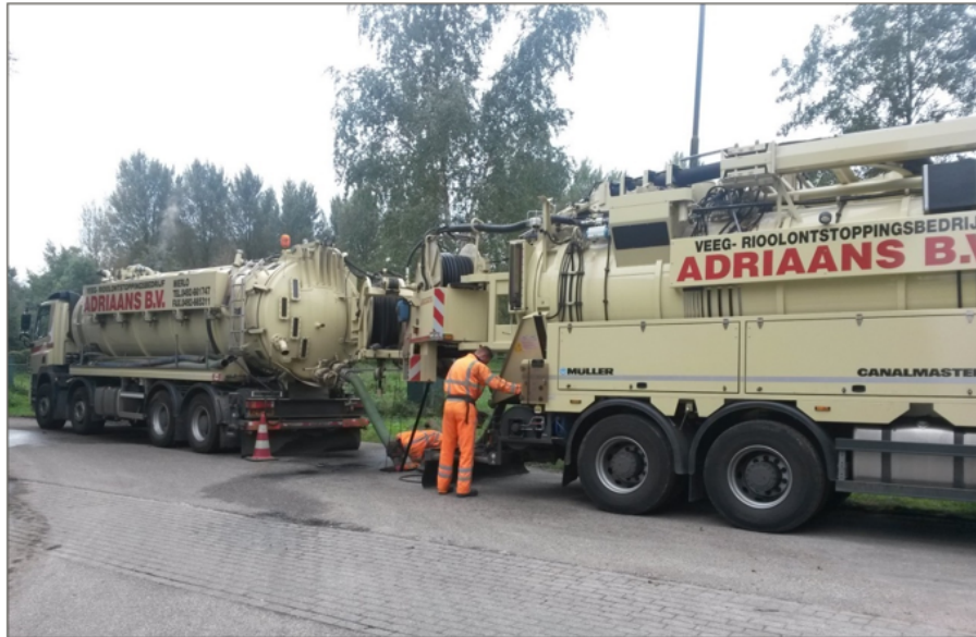
Afbeelding 14 Uitvoering van rioolreiniging
