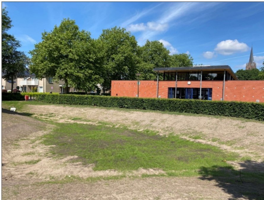
Afbeelding 6 Ruimte voor water in bestaand stedelijke gebied, aangelegde wadi aan Heer Dickbierweg
