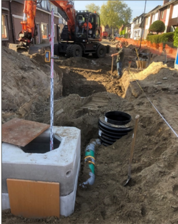
Afbeelding 15 Vervanging van riolering
