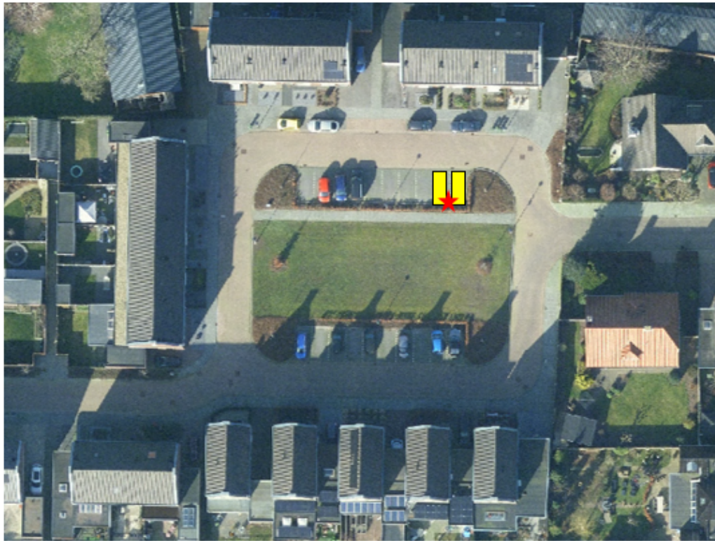
Locatie oplaadpaal met parkeerplaatsen uitsluitend voor opladen elektrische voertuigen
