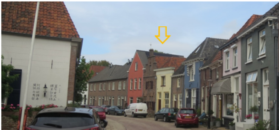
Ad. 3 Op het zijdakvlak van pand langs de Bergstraat, beperkt zichtbaar vanaf openbaar gebied.
