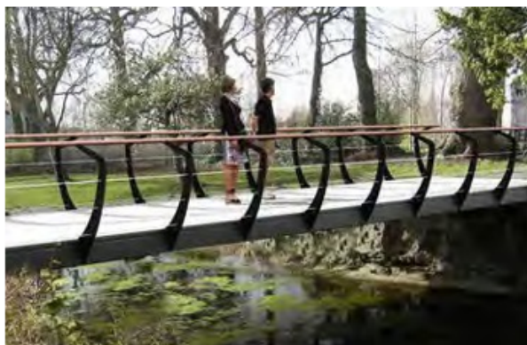
Voorbeeld brug voor langzaam verkeer bij Hotel de Inval
