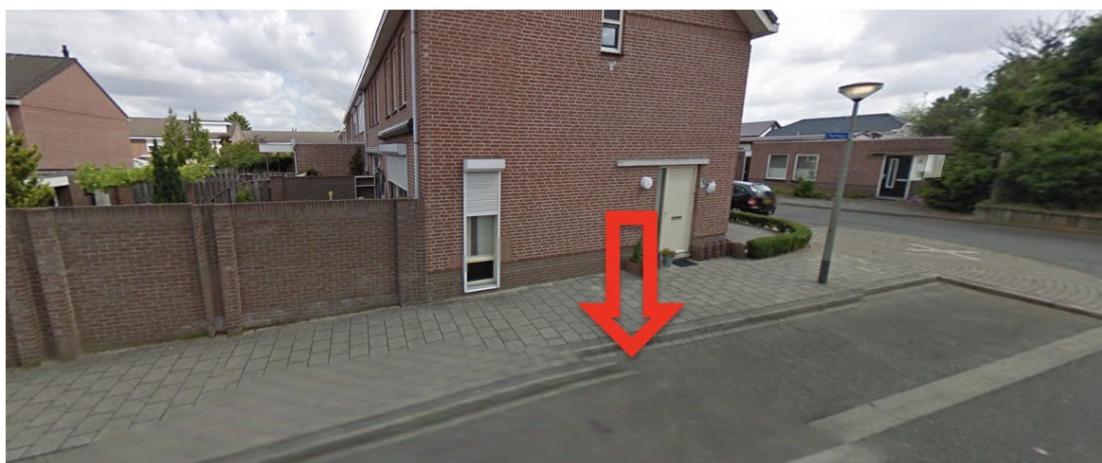
Laadpaal ID 0935-325: Pastoor Lanckohrstraat 15, 6225BG Maastricht Coördinaten: 50.862808117935145, 5.730748502066859
