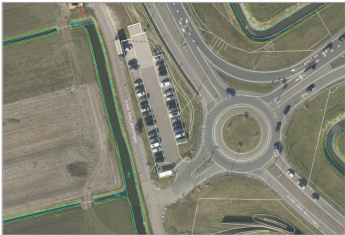
Carpoolplaats Klaas Engelbrechtsweg Schipluiden
