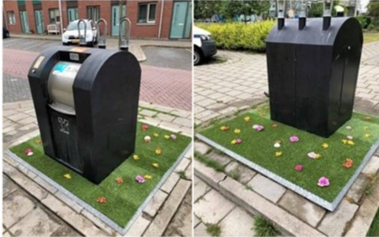
Figuur 14: voorbeeld van ondergrondse containers
