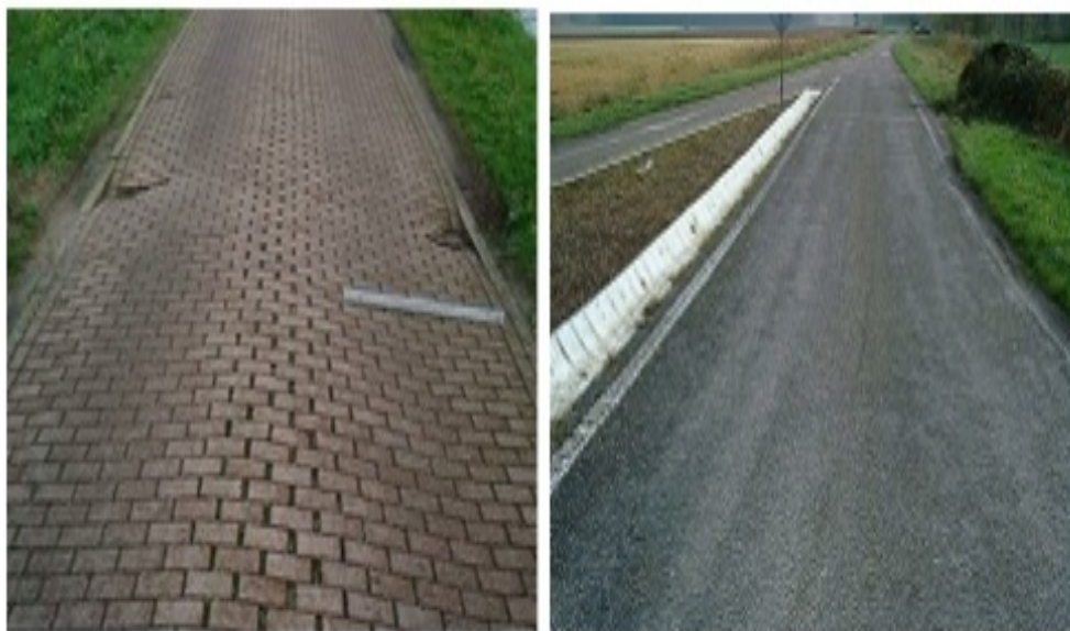
Figuur B2-2 Schades dwarsonvlakheid en rafeling
