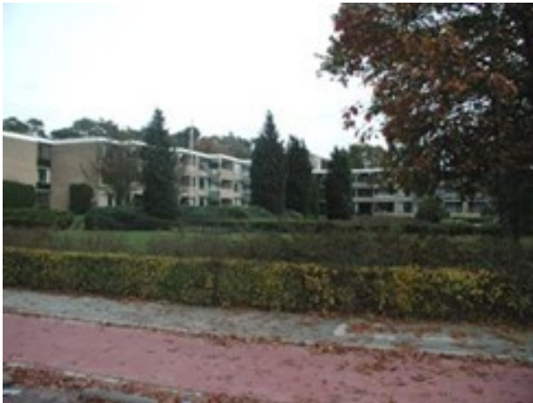
5. Serviceflat De Soester Duinen met tuin en waterpartij aan de voorzijde draagt bij aan het rustige beeld van de straat.
