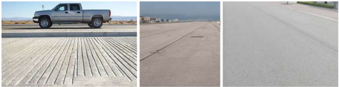
De rijweg wordt uitgevoerd in lichtgrijs asphalt waarbij in de belijning door middel van zwartkleurige 'streetprints' de rijbaan visueel wordt versmald
