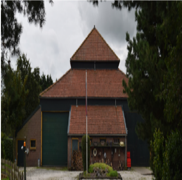
Hier is het opgetilde dak van de schuur goed te zien. (Kathrin Vierveijzer)
