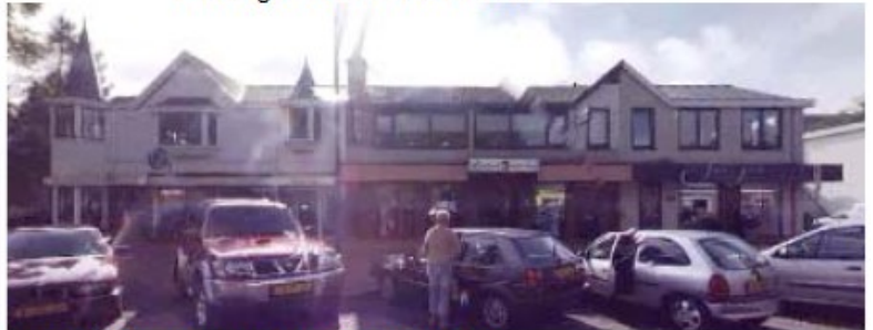
'brede gevel met architectonische geleding'
