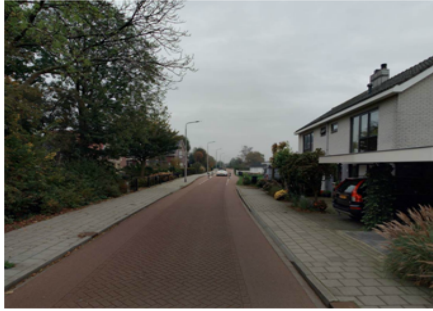
Elementenverharding zonder schades, Koningin Julianalaan
