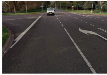
Asfaltweg zonder schades, Van de Madeweg
