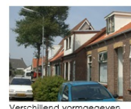
Verschillend vormgegeven dakkapellen aan de Middenstraat.
