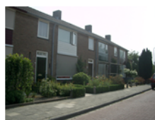
Blokverkaveling met verschillende prefab gevelinvullingen.
