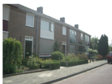
Verscheidend kleurgebruik bij gelijke gevelindeling in Wisenkerke.
