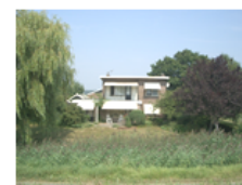
Afwijkende vormgeving van agrarische woonbebouwing.
