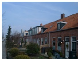
Verscheidend vormgegeven dakkapellen aan de Colijns-plaatsweg.
