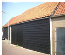
Karakteristieke houten gevelbekleding Colijnsplaat.
