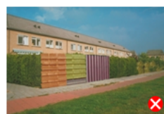
Niet passend door onsamenvangend materiaal- en kleurgebruik.
