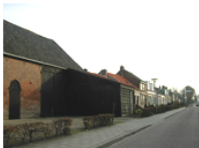
Lintbebouwing langs de Dorpsweg.
