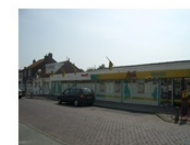
Contrasterende architectuur aan de Oostvoorstraat.
