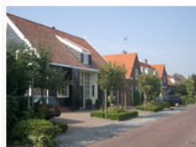
Voormalige agrarische bedrijfsbebouwing aan de Ringweg.
