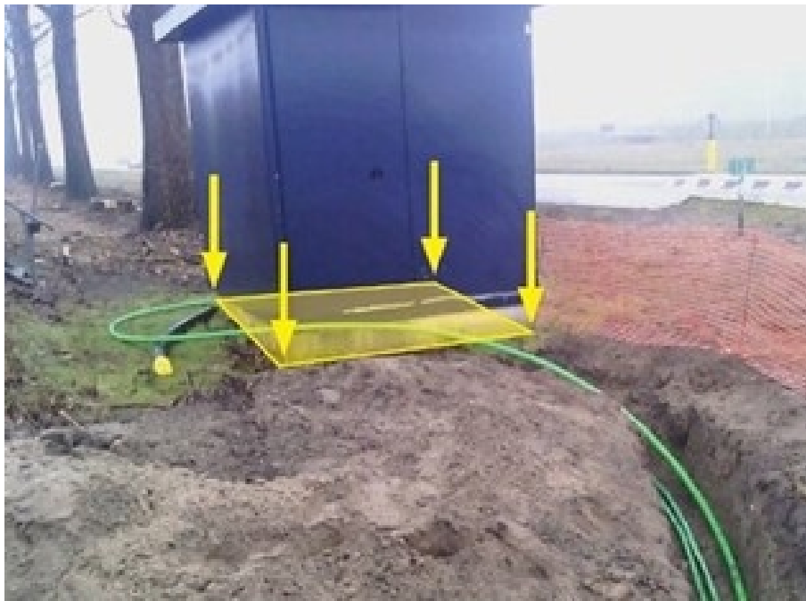
Figuur 1 Bovengronds object, ruimtebeslag groter dan 4 m 2 : Contour vastleggen met de Z-waarde gelijkgesteld aan het maaiveld.
