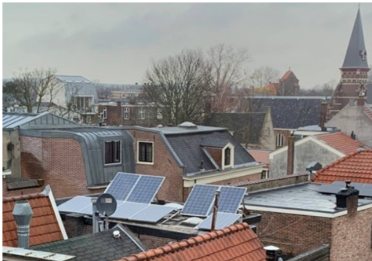
Panelen op platte daken in binnenstad
