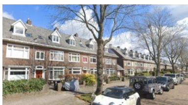
Doorlopende dakvlakken van complexmatig ontwikkelde woningen in Haarlem Noord, Zaanenlaan
