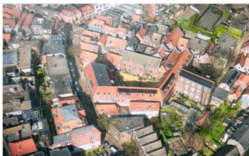
Panelen op schuine daken uit het zicht, Rosenstock-Huussy Huis aan de Antoniestraat
