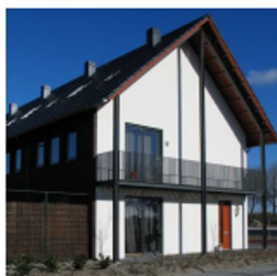
Kopgevel aan parkpad
