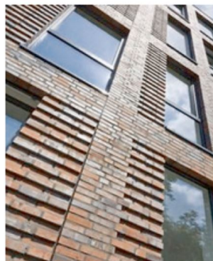
Detail in metselwerk
