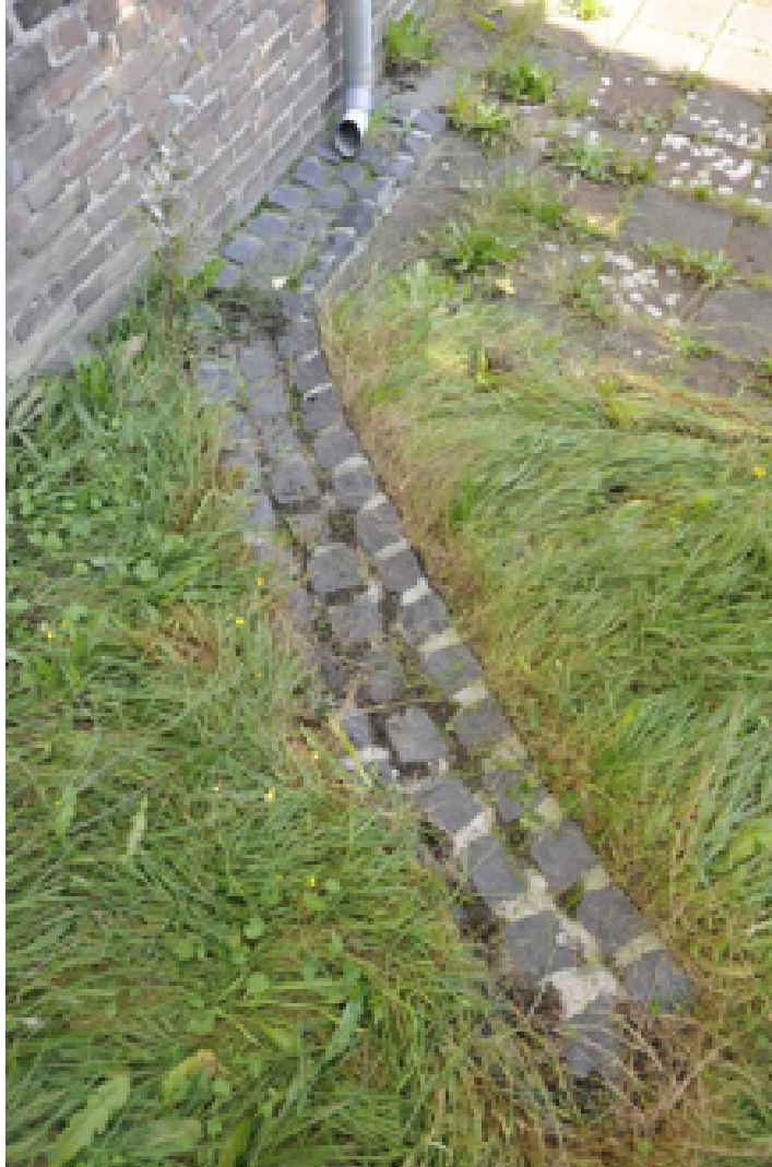
Figuur 15: Afkoppeling regenpijp - Bron: GAW Stichting Rioned
