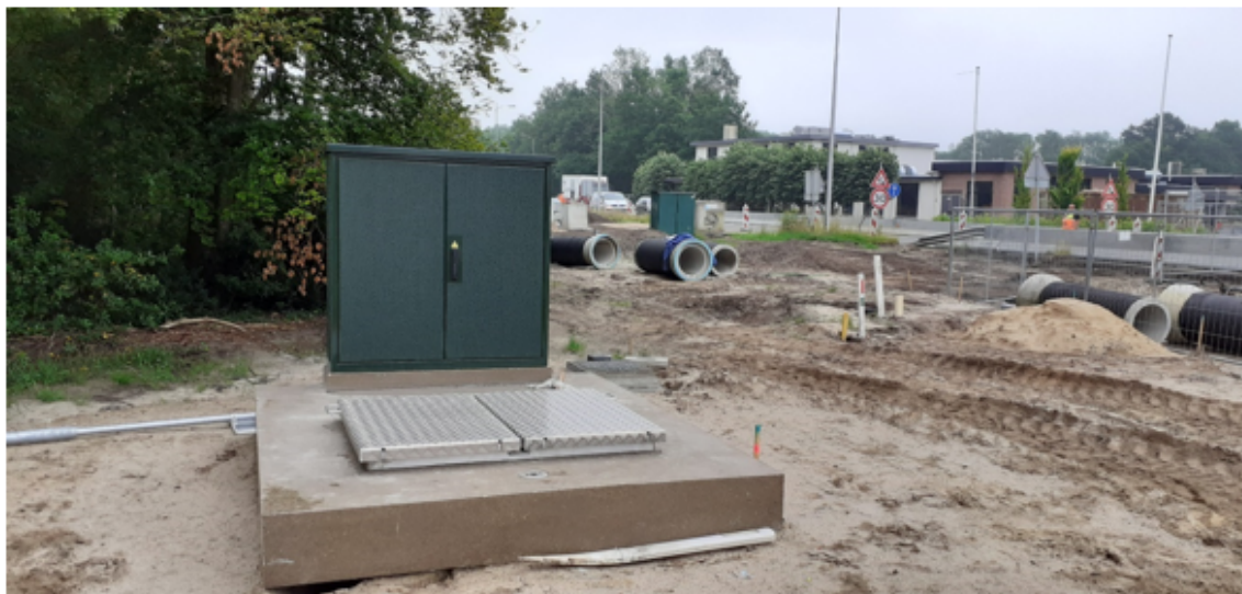
Figuur 10: Rioolgemaal Eperweg en aanleg nieuw riolering
