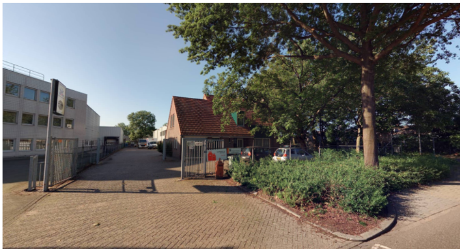
Foto: kamerbewoning bedrijfswoning
