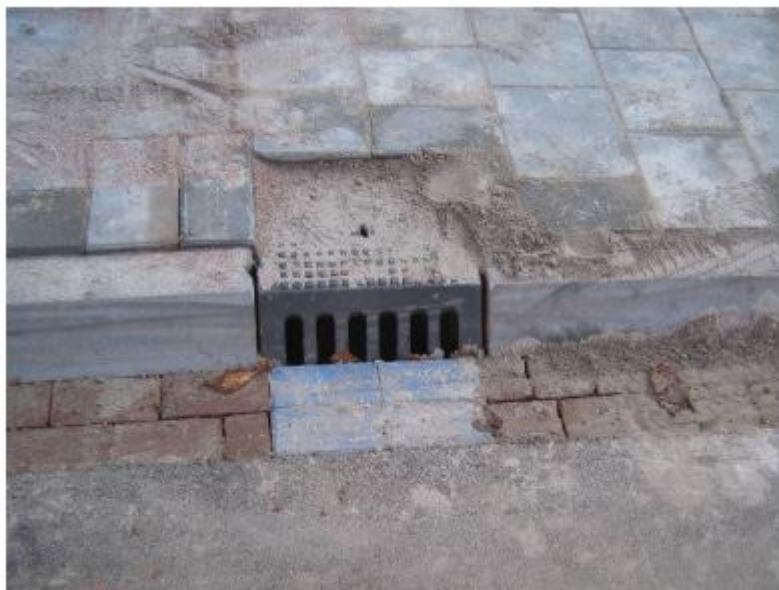
figuur 4: Trottoirkolk voor schoon hemelwater
