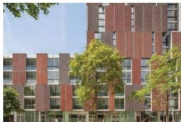
Gevel met afwisselend open en gesloten vlakken, diversiteit in metselwerk
