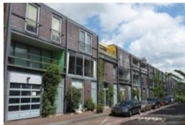
Diversiteit open en gesloten vlakken binnen een stramen, toegang parkeergarage met industriële uitstraling
