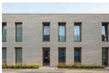
Gesloten 'gevel' met regelmatige raamverdeling
