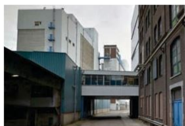
Afdeling met staalplaat, toevoeging kleur blauw
