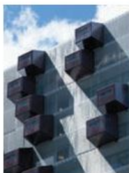
Gevel met galerij, toepassing half transparant hekwerk met losse bergingen aan de gevel gehangen
