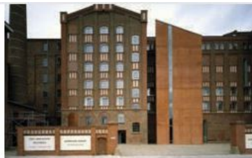
Nieuwbouw met eigen moderne uitstraling maar passend bij industrieel monument
