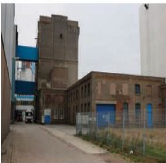
Kabelhuizen en machiniekamer 1911/1916
