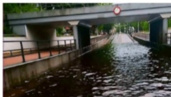
Tunnel Koornbeursweg, Heerenveen. FOTO AJANCA VEEER
