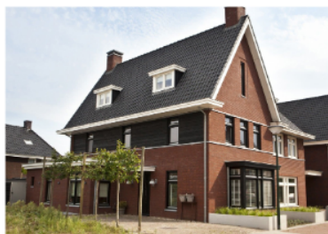
tweezijdige orientatie, twee voorgevels bij een hoeksituatie
