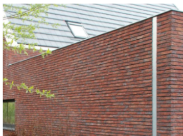
detailering is modern, zorgvuldig en afgestemd op de architectuur
