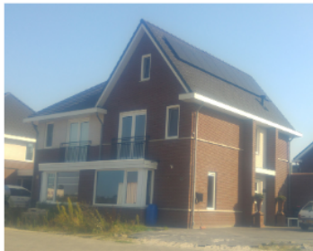
elke woning is anders door een andere kaprichting, gevelindeling en kleurstelling
