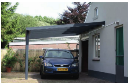
Aangebouwde carport licht hellend dak
