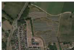
1:5 Solarpark De Kwekerij Steekweg, Hengelo
