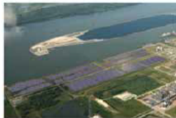
1:3 Zonnepark Shell Sheltraain, Moerdijk
