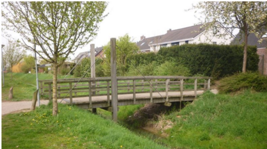
Figuur 4: Een houten brug (levensduur ca. 30 jaar)
