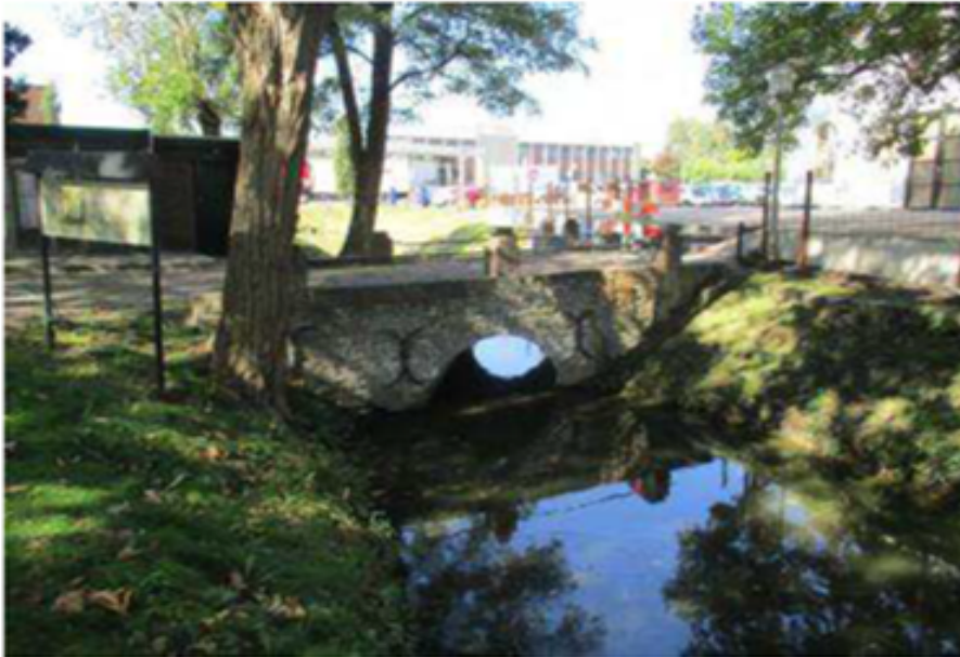
Figuur 5: Metselwerkbrug aan de Kinkelenburglaan 4 te Bemmelen
