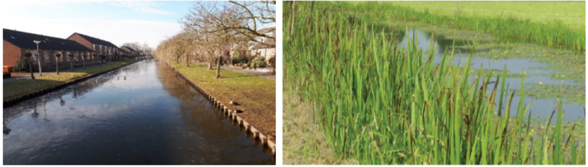
Figuur 1. Een voorbeeld van een beschoeide oever in de gemeente Vijfheerenlanden (links) en een voorbeeld van een natuurvriendelijke oever (rechts)
