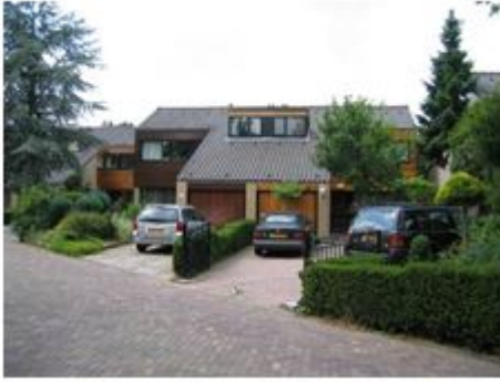
Deze twee-onder-één-kap woningen staan enigszins gedraaid ten opzichte van de openbare weg. De kap loopt door tot op de garage
