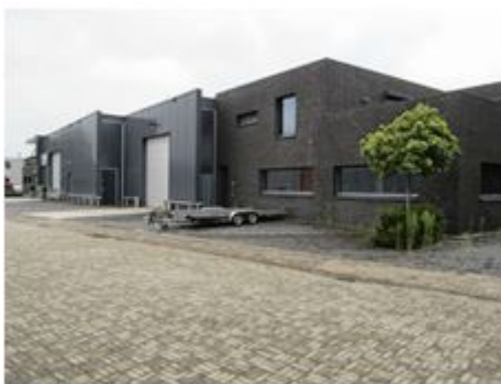
Bedrijfspannd met gevelgeleding
