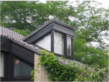
De woningen zijn voorzien van een standaard dakkapel
