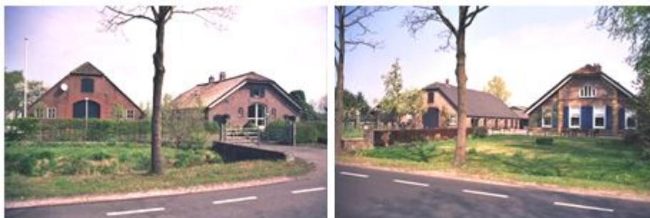
Hallenhuisboerderijen aan de Leusbroekerweg
