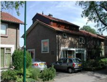
Voorbeeld van een dakopbouw
