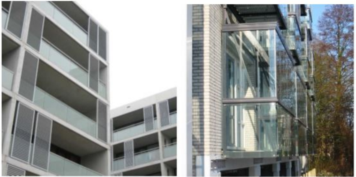
Figuur 8 Afscherming met gevelelementen (links) met een loggia (rechts)
