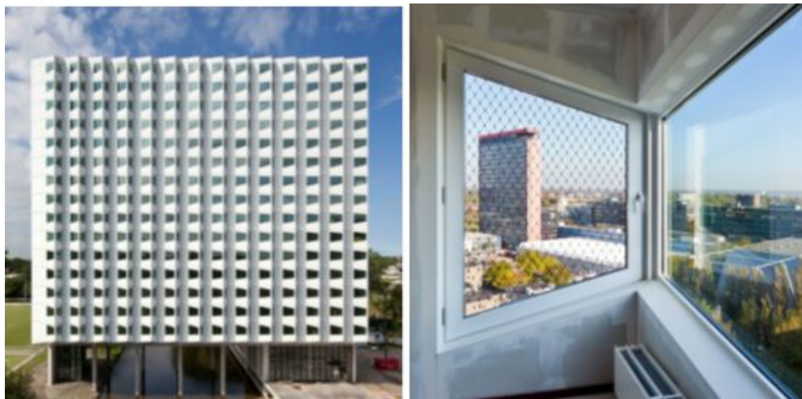
Figuur 6 Zaagtanggevel bij een geluidsbelasting van de zijkant.
