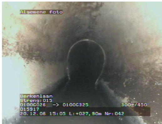
Rioolinspectie met een robotcamera
