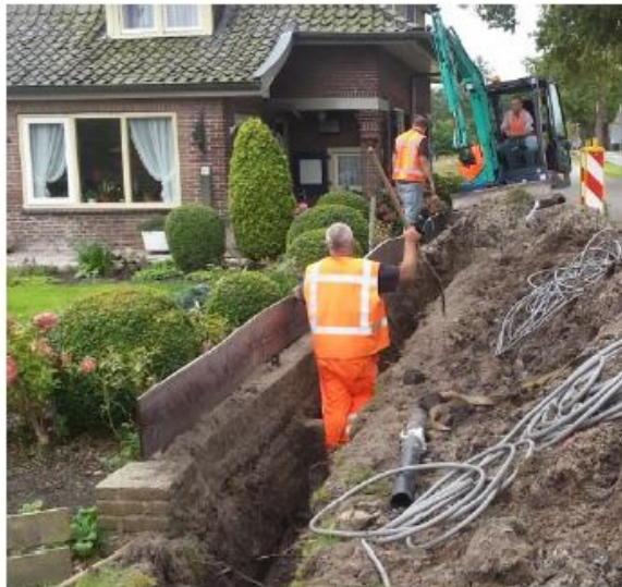
Aanleg drukriolering Arnhemseweg
