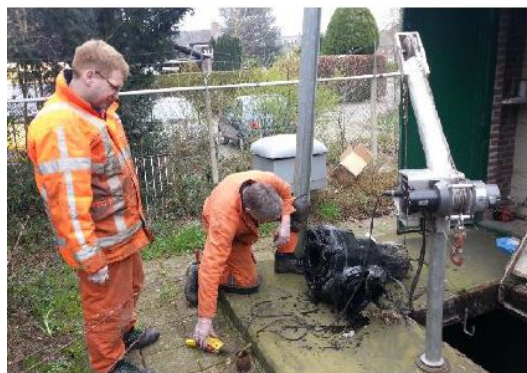
Onderhoud rioolgemaal Leusden-Zuid
