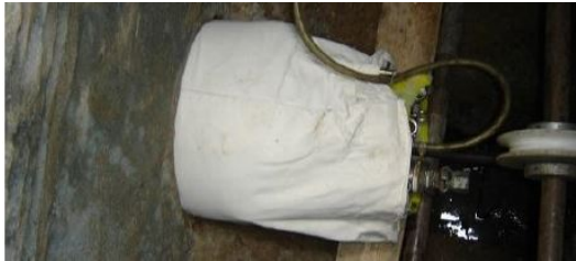
Reliningskous wordt ingebracht
