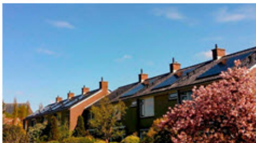
Regelmatige plaatsing zonnepanelen op complexen
