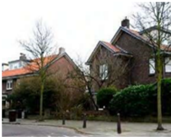
De nokhoogte van aanbouwen is lager dan die van het hoofdgebouw
