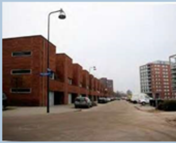
Gevarieerde clusters woningen aan brede straten
