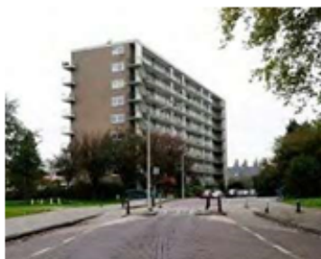
Gebouwen oriënteren op de belangrijkste openbare ruimte(n)
