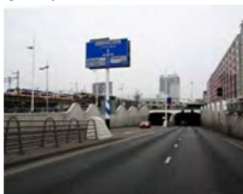
Een deel van de Schipholweg ligt ondergronds
