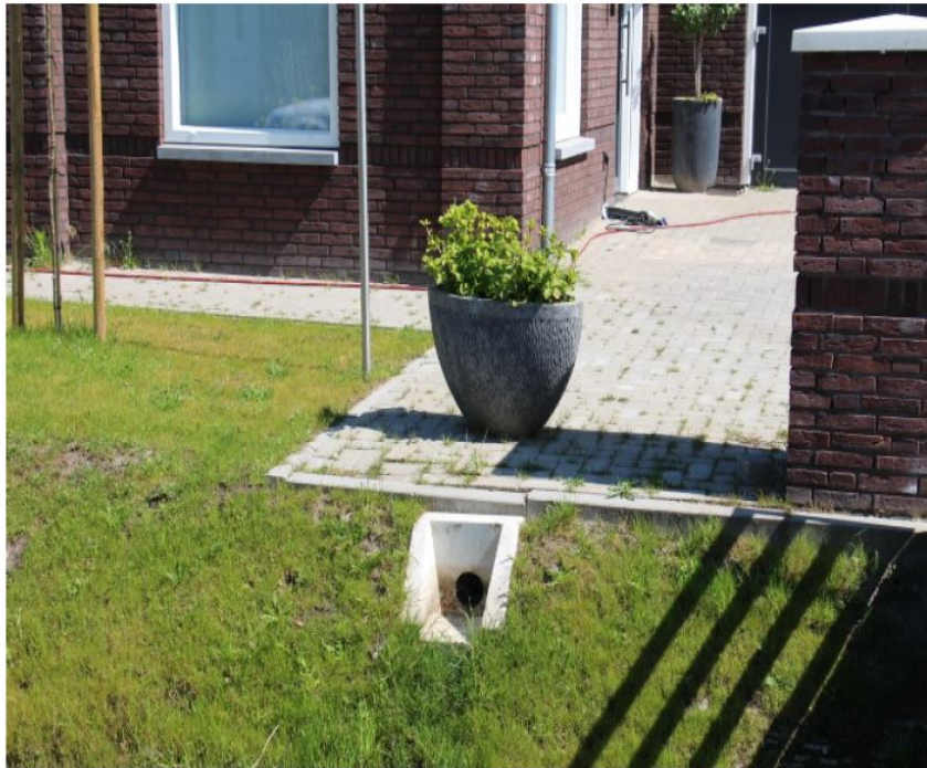
Regenwater afgekoppeld naar groen en oppervlaktewater
