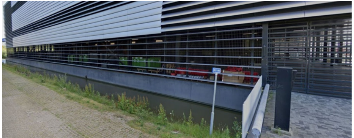
Voorbeeld van opslagruimte onder het gebouw, gracht en hek, Sciencepark Amsterdam
