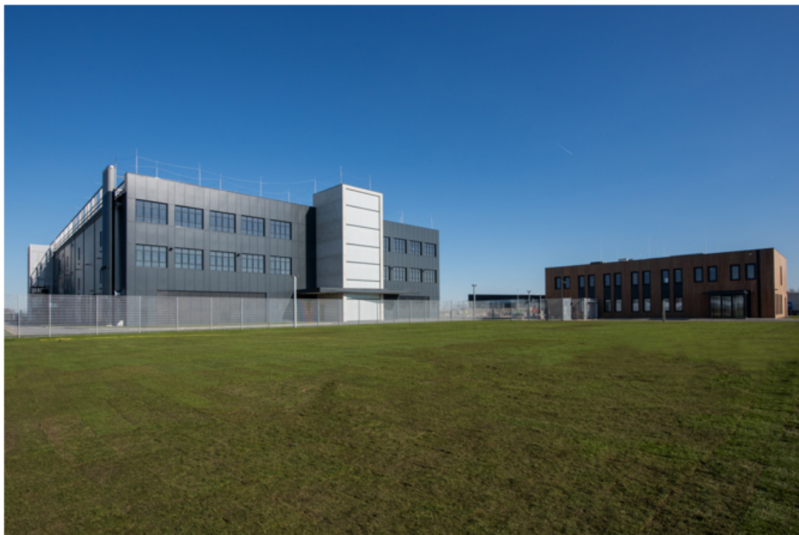
Nieuwe datacenter van E-Shelter op Corneliahoeve (bron: website datacenter.com)
