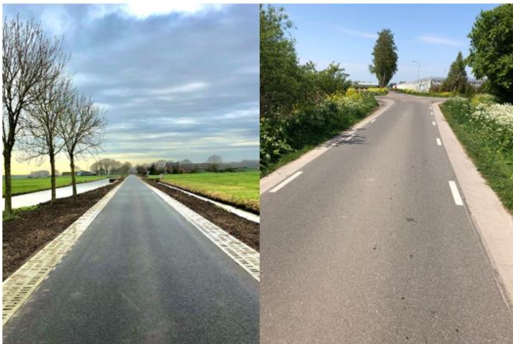
Weg voorzien van gewapende bermverharding
