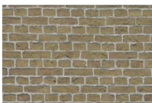
M6. Metselwerk, IJsselstenen, kruisverband.
