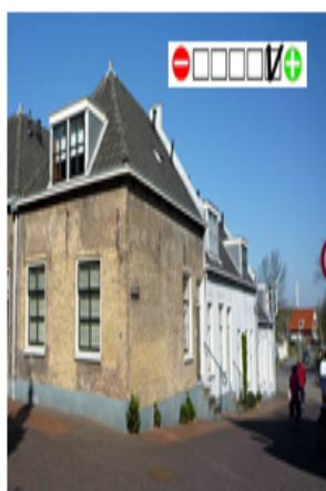
Kerkstraat 1-9, hoek Dorpsstraat. Het hoogteverschil is op een natuurlijke wijze verwerkt in de straatwand.
