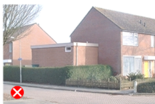
zijaanbouw te hoog
