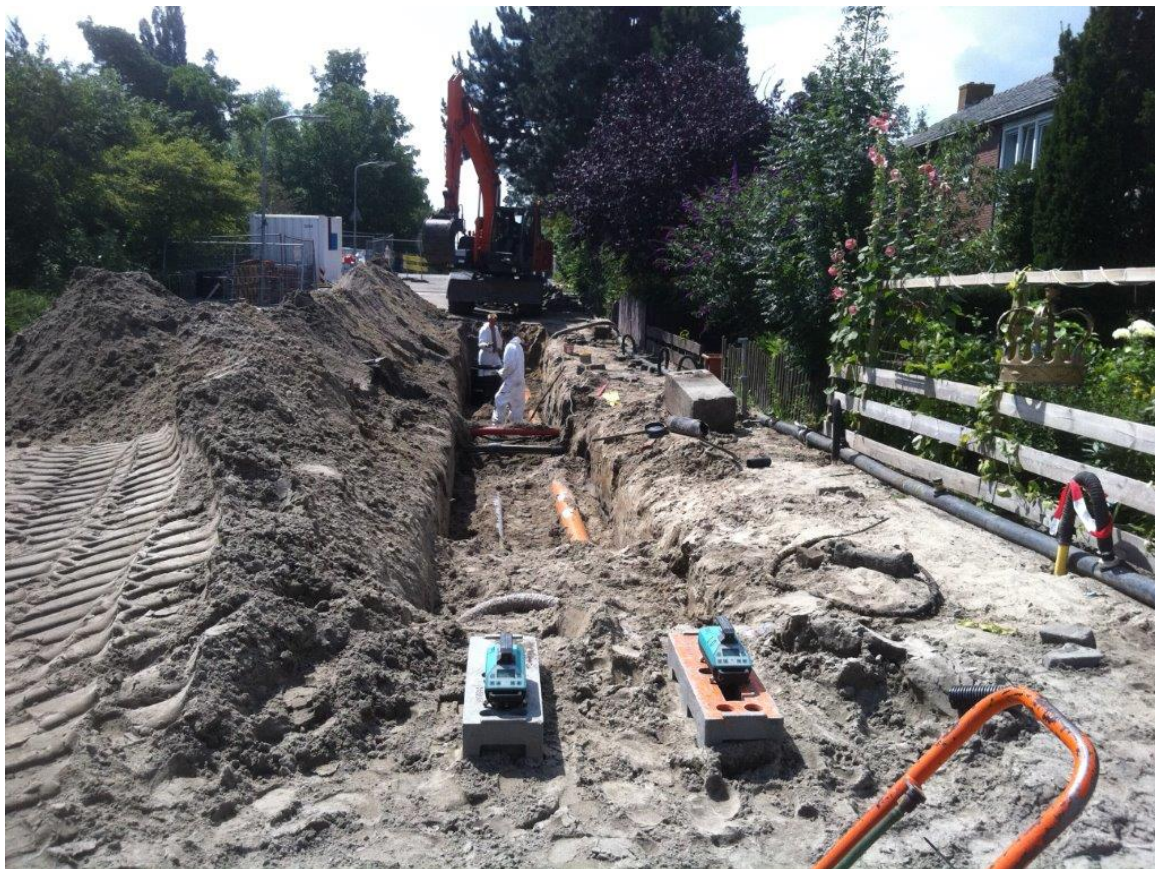
Figuur 7 - Aanleg van een gescheiden stelstel in Landsmeer (Bron: gemeente Landsmeer)
