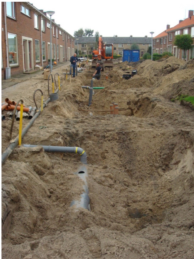
Figuur 8 – Rioleringswerken (Bron: gemeenten Oostzaan en Wormerland)
