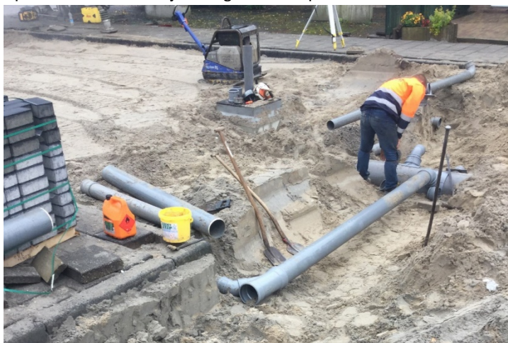
Figuur 11 – Afkoppelen van de hemelwaterafvoer in Monnickendam (Bron: gemeente Waterland)
