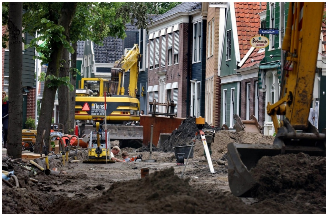
Rioolwerkzaamheden gemeente Zaanstad (Bron: Beeldbank Zaanstad)
