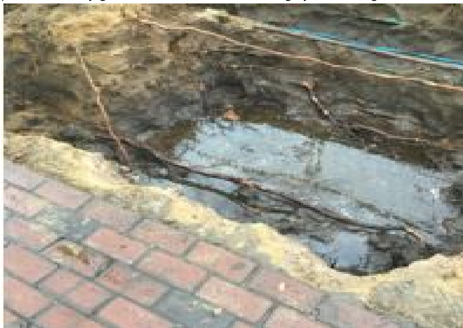
Figuur 6: Kabels, leidingen, boomwortels en grondwater
