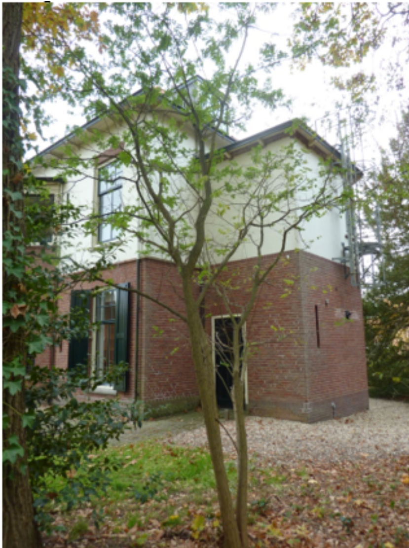
Oost- en noordgevel
