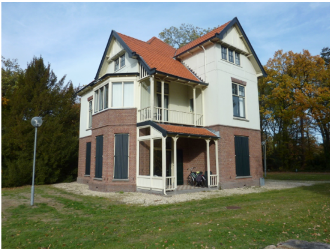
Levenspad 5, gezien vanaf het zuiden, zuid- en westgevel
