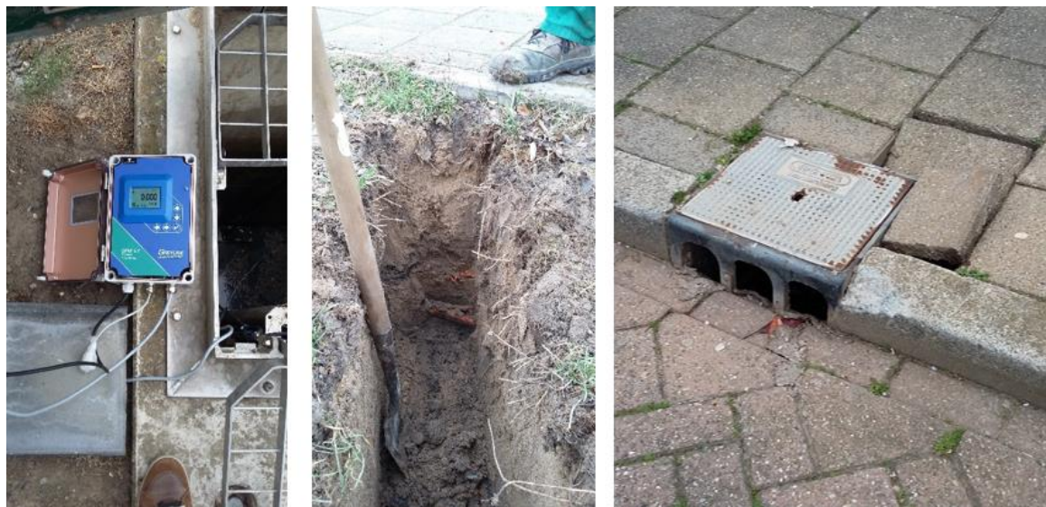
Figuur 8 - Het controleren van het lozingsdebiet van een gemaal (links), het graven van een proefsleuf om de ligging van kabels en leidingen te onderzoeken (midden) en schade aan kolken als gevolg van vuurwerk (rechts).
