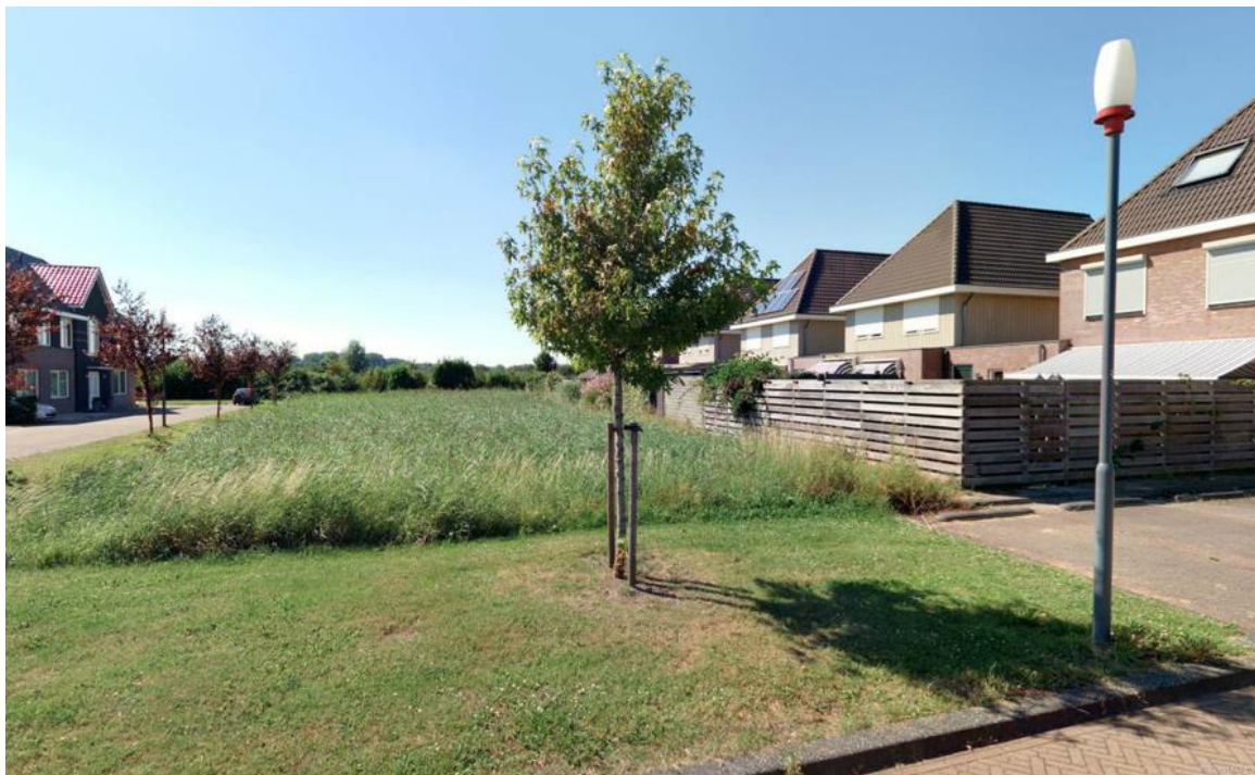
Figuur 7 - Een wadi: een verdiepte groene zone die onder water kan lopen als dat nodig is om overlast op straat tegen te gaan. Het vormt tevens een filter- en reinigingsvoorziening voor het passerende hemelwater.
