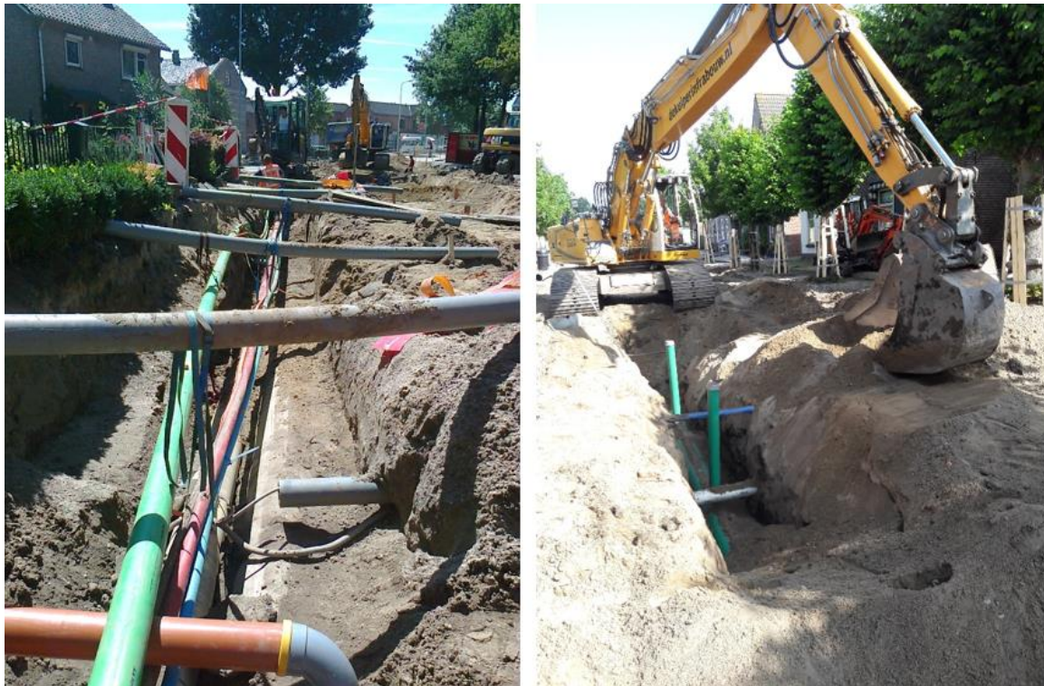
Figuur 6 - Vervangen gemengd riool door gescheiden riool in Geldermalsen (links, Tunnelweg) en Asperen (rechts, Achterstraat). Bij de Tunnelweg werd tegelijkertijd de voorzijde van de woningen / daken afgekoppeld.
