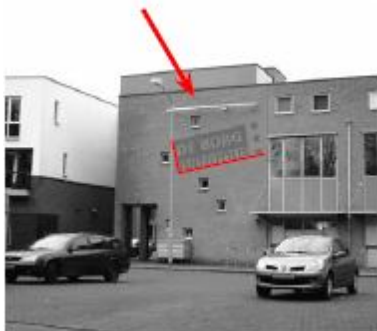
Gebouw met een maatschappelijke functie: reclame kan worden aangelicht.
