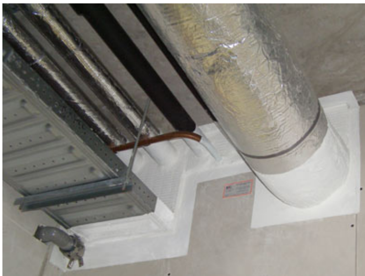
Figuur: Branddoorvoeringen
