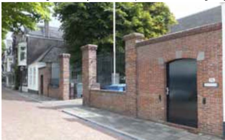
Bijgebouwen en erfafscheiding als één afgestemd geheel vormgegeven. Gemetselde tuinmuren en bouwwerken grenzend aan openbaar gebied hebben de voorkeur.
