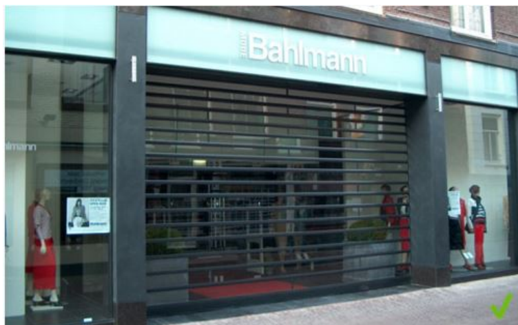
Rolluiken aan de buitenzijde alleen als het niet anders kan en nagenoeg volledig met traliewerk of glasheldere doorkijkopeningen.
