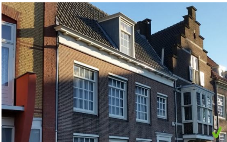
Dakkapellen in stijl van pand vormgeven. Hierbij is gebruik van zink voor zijwanden prima mogelijk.
