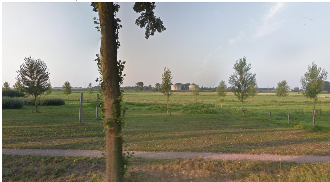
Afbeelding 10 Zicht op bedrijventerrein Zevenellen (augustus 2016) vanuit de Dorpsstraat. Op de voorgrond is de natuurlijk ingerichte zone zichtbaar. Op de achtergrond zijn de overgebleven koeltorens van de oude energiecentrale te zien.
