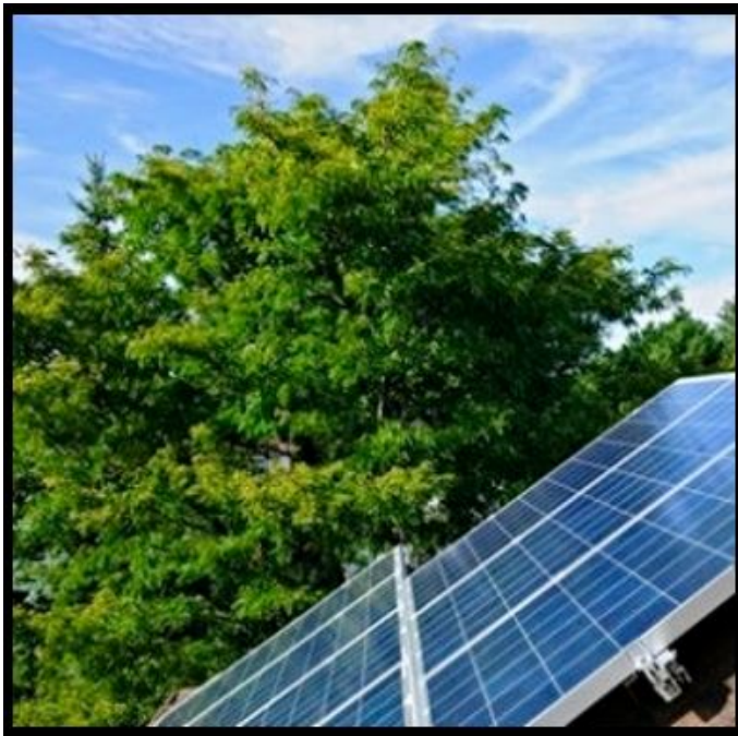
Figuur 7: Bomen kunnen invloed hebben op de energieopbrengst van zonnepanelen.
