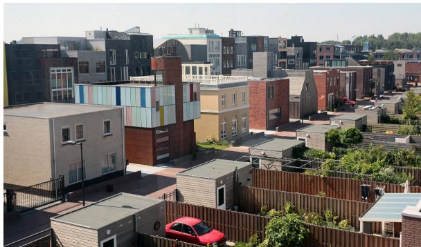
Afbeelding: Dakopbouwen op Steigereiland
