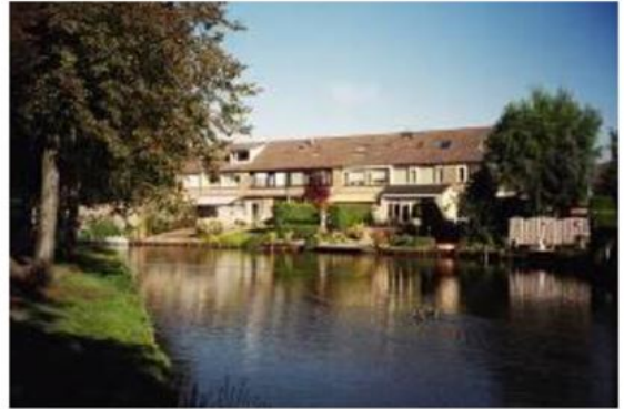
Uitbouw aan de achterzijde van de Schubertstraat
