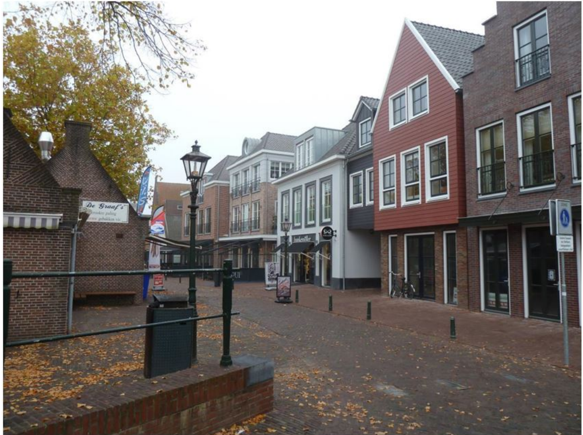
Nieuwbouw ingepast in de gevelwand van het Spuiplein
