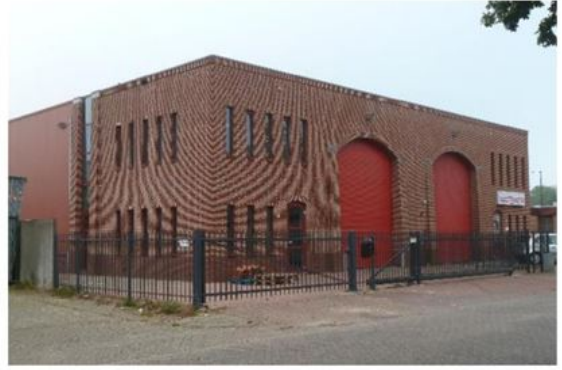
Vernieuwing op industrieterrein Zuidwenk
