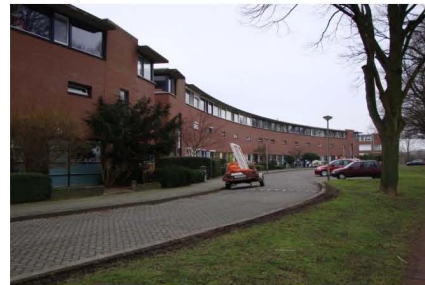
Nieuwbouw aan de Jachthoornstraat
